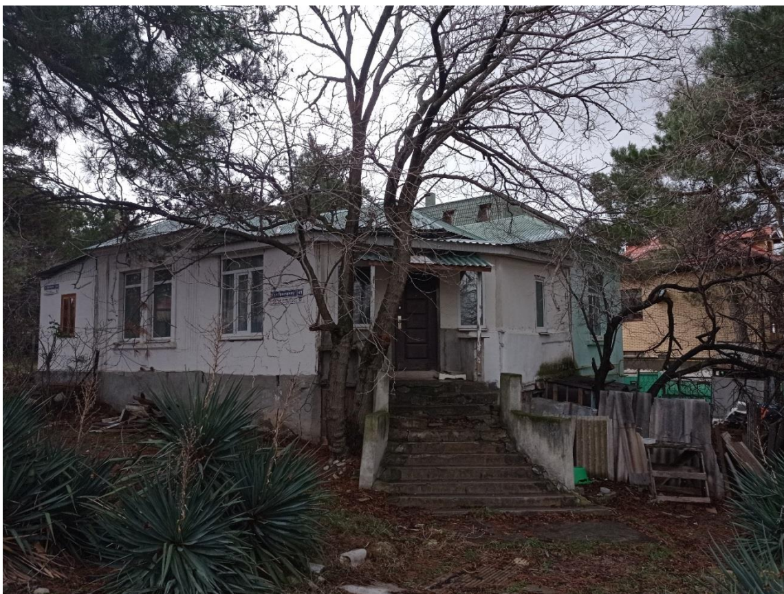
Рис. 3. Здание на ул. Просторной, д. 4.
