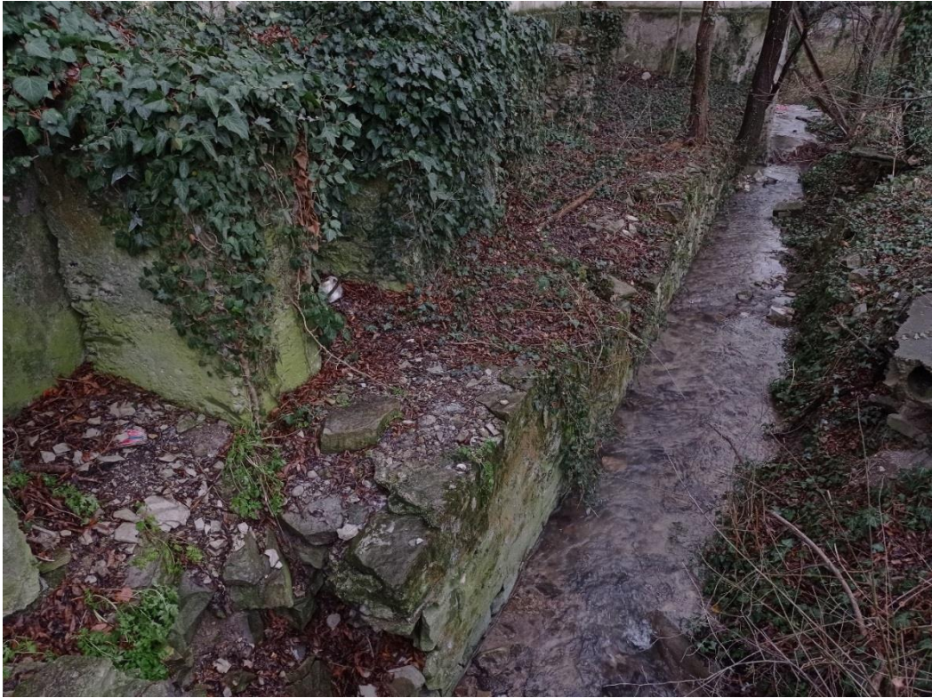
Рис. 8. Хорошо сохранился мощный фундамент дома и водосток.
