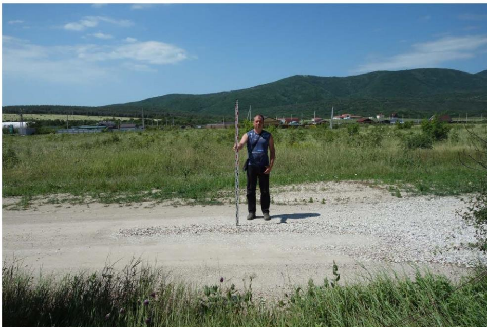
Рис. 22. Краснодарский край. Город-курорт Геленджик. Строительство примыканий в границах полосы отвода автомобильной дороги общего пользования федерального значения М-4 «Дон». Территория исследований. Точка фотофиксации 5. Вид с севера.
