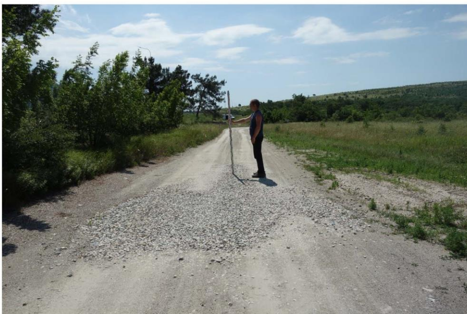
Рис. 21. Краснодарский край. Город-курорт Геленджик. Строительство примыканий в границах полосы отвода автомобильной дороги общего пользования федерального значения М-4 «Дон». Территория исследований. Точка фотофиксации 5. Вид с запада.
