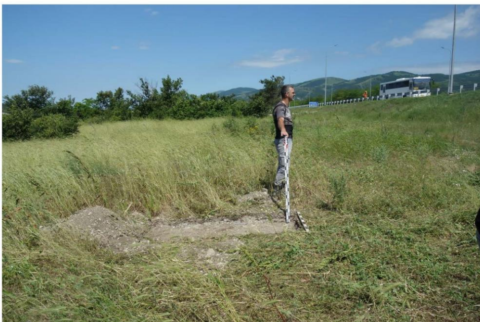
Рис. 30. Краснодарский край. Город-курорт Геленджик. Строительство примыканий в границах полосы отвода автомобильной дороги общего пользования федерального значения М-4 «Дон». Шурф 2 после окончания работ. Вид с востока.
