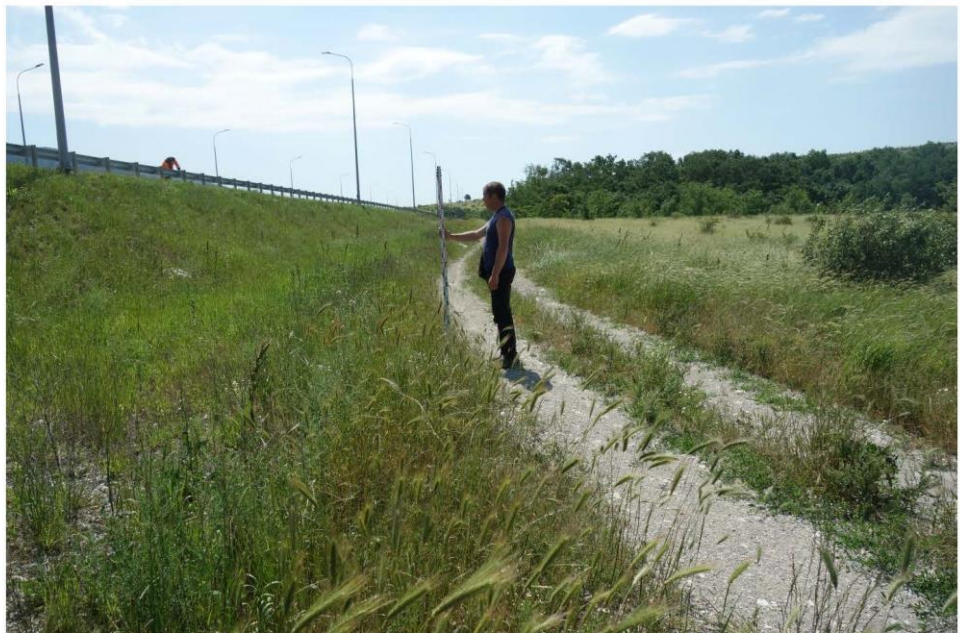
Рис. 17. Краснодарский край. Город-курорт Геленджик. Строительство примыканий в границах полосы отвода автомобильной дороги общего пользования федерального значения М-4 «Дон». Территория исследований. Точка фотофиксации 4. Вид с запада.
