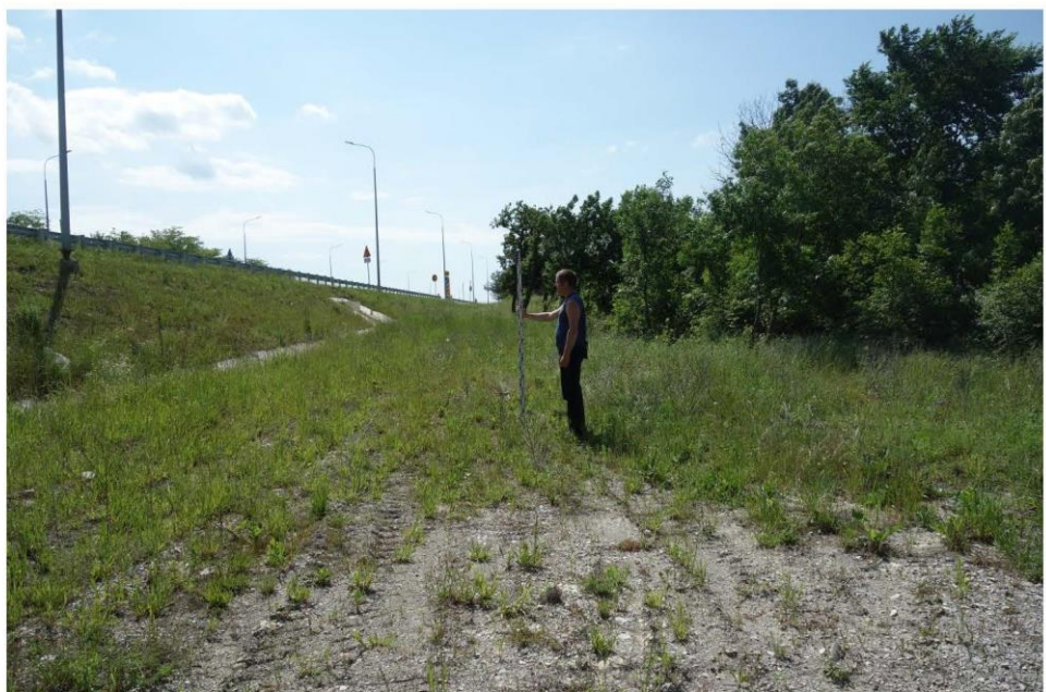
Рис. 13. Краснодарский край. Город-курорт Геленджик. Строительство примыканий в границах полосы отвода автомобильной дороги общего пользования федерального значения М-4 «Дон». Территория исследований. Точка фотофиксации 3. Вид с запада.
