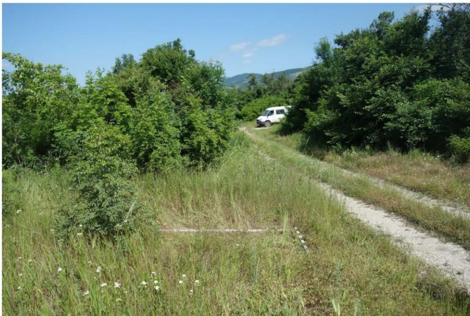
Рис. 25. Краснодарский край. Город-курорт Геленджик. Строительство примыканий в границах полосы отвода автомобильной дороги общего пользования федерального значения М-4 «Дон». Шурф 1 до начала работ. Вид с востока.
