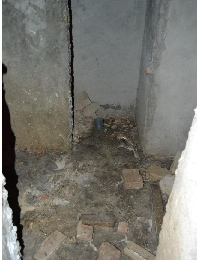
Фото № 8. Помещения №№ 11, 12 (нумерация в соответствии с техническим паспортом) оцениваемого объекта
