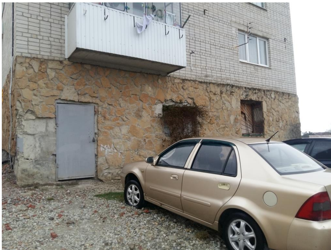
Фото № 2. Вход в оцениваемые нежилые помещения в цокольном этаже здания многоэтажного жилого дома (со стороны лесополосы)
